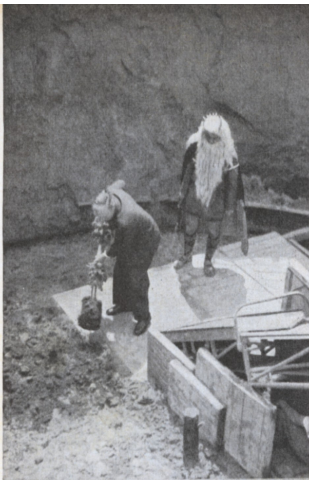
Der erste Spatenstich
