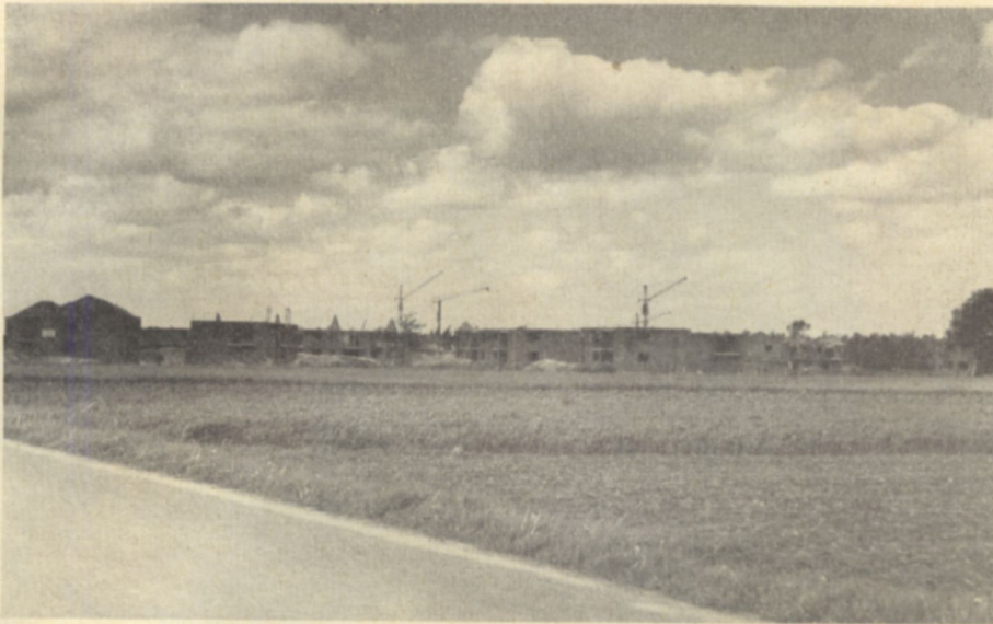
Die im Bau befindliche Siedlung Gerderath
