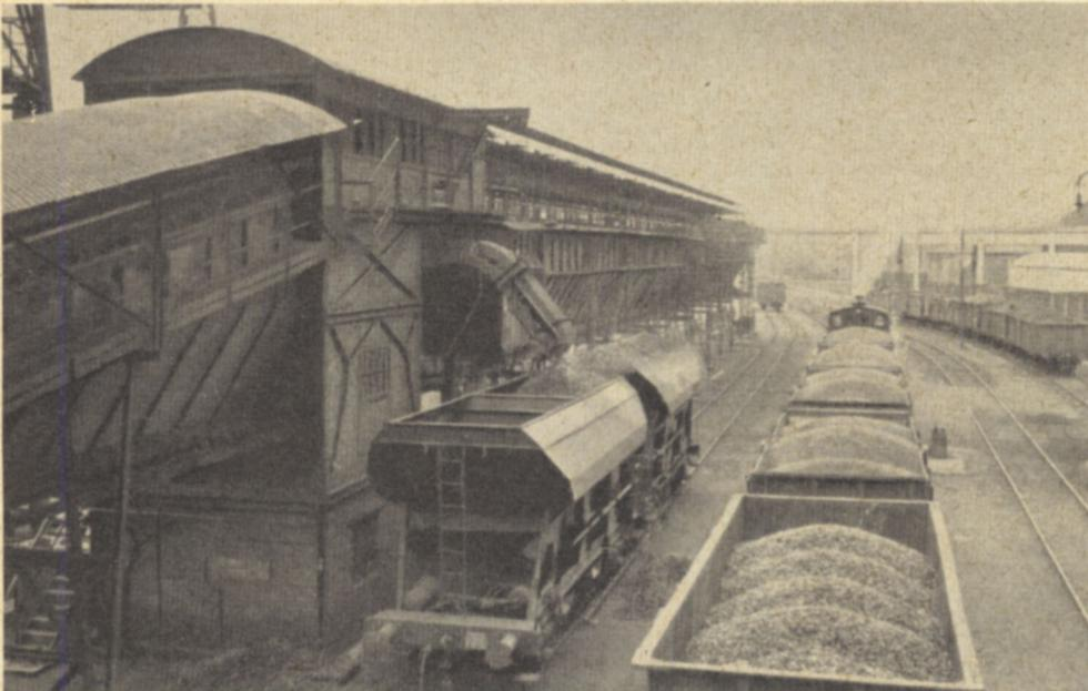
Links: Brikettkühlanlage mit Verladeeinrichtung
