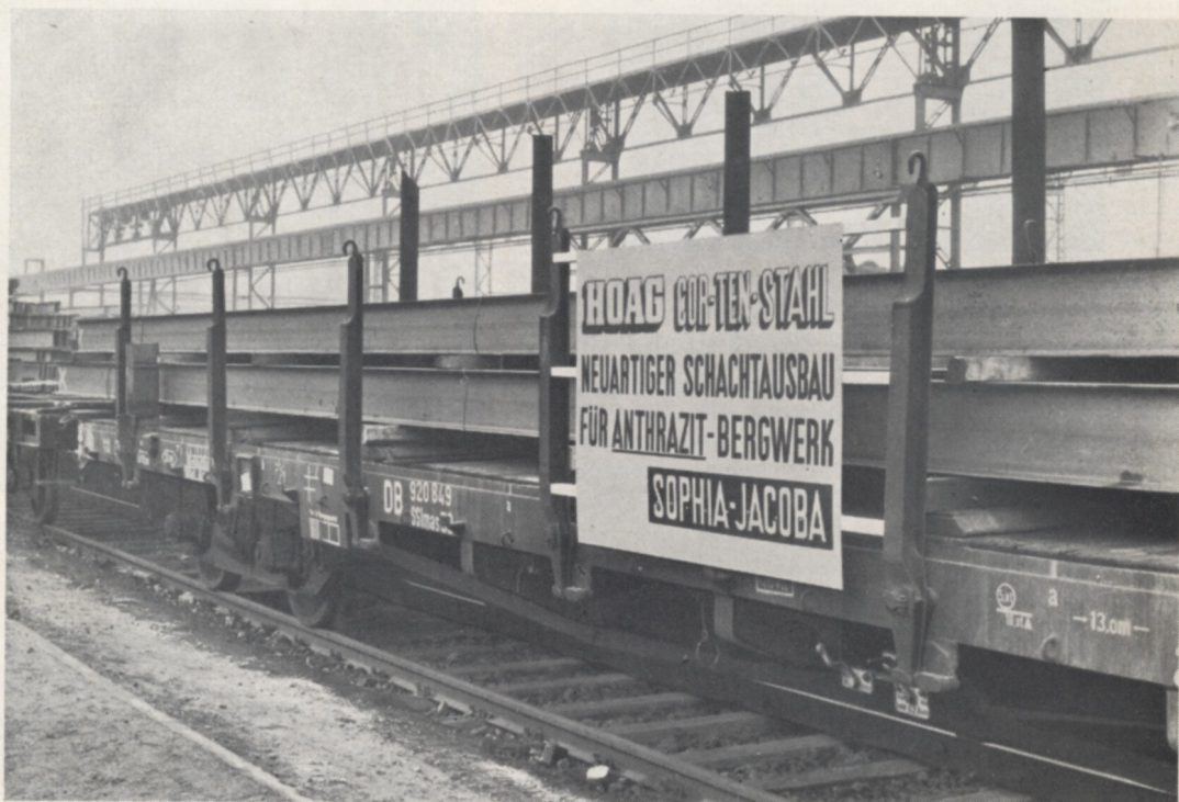
Cor-Ten-Stahl wird für Schacht 6 in Oberhausen verladen
