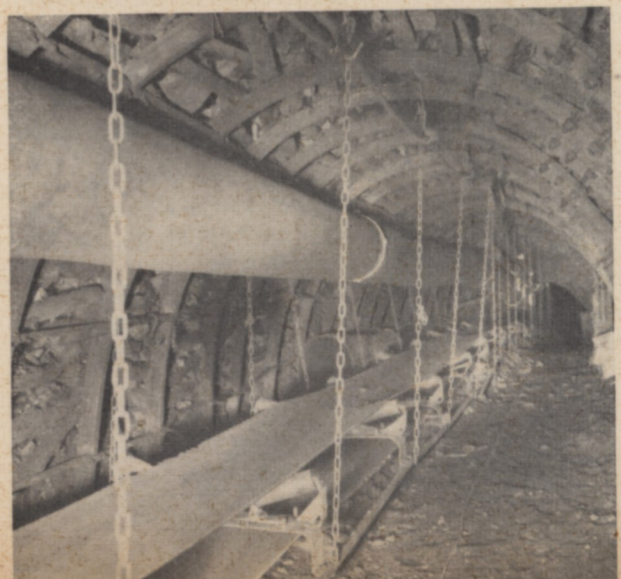
Sinnvolle Querschnittseinteilung in der Schrapperstrecke Groß-Athwerk ermöglicht schichtensparenden Materialtransport
