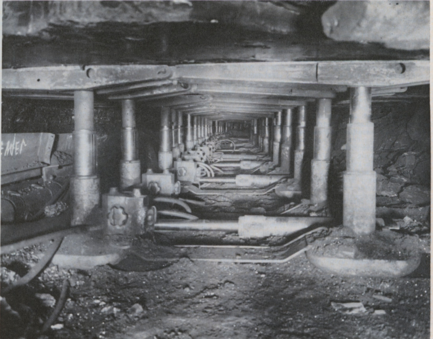
Hydraulische Ausbaugestelle der Gewerkschaft Eisenhütte Westfalia im Streb Flöz Rauschenwerk, Revier 25
