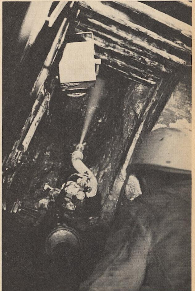
Bild oben: Kontrolle einer Versuchsbohrung über eine Fernseh-anlage.
