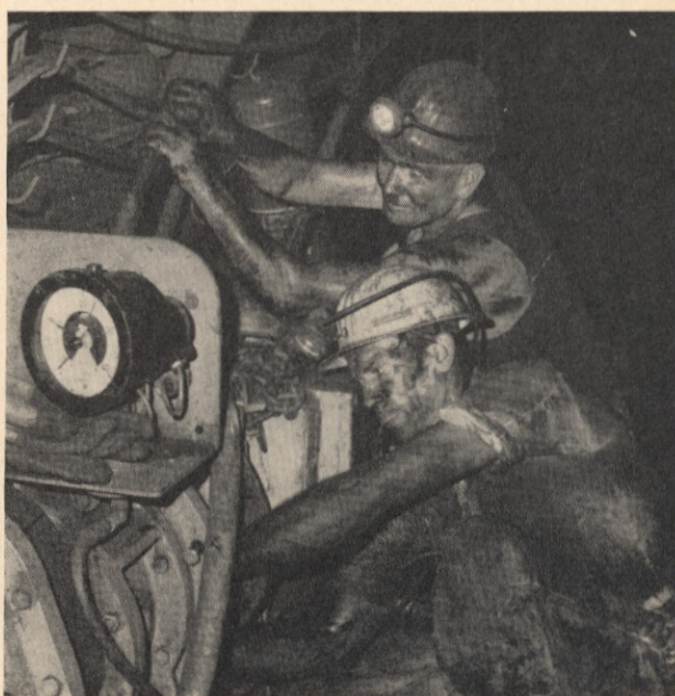
Beim Auswechseln der Kupplung einer Pumpenanlage.
