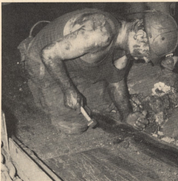
Vorbereitungsarbeiten zum Trennen des Panzerförderers.
