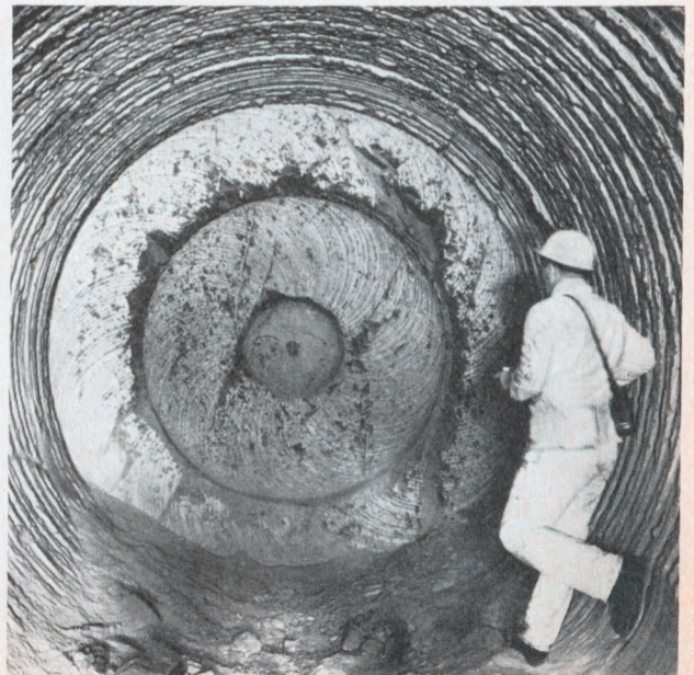
Eine mit moderner Streckenvortriebsmaschine aufgefahrne Strecke.
