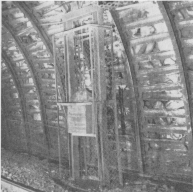
2.) Pneumatisch wirkende Spannvorrichtung mit zwei Zylindern montiert.
