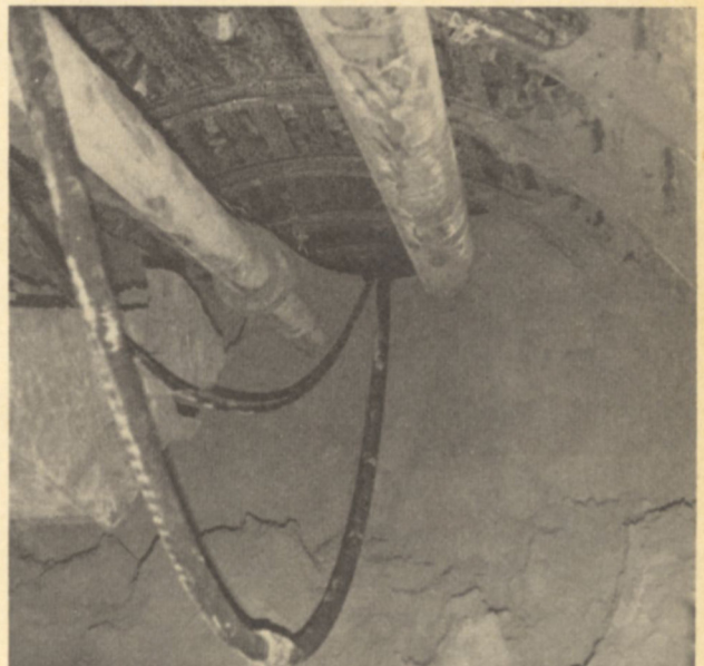
Eine Sandladestelle auf der 4. Sohle
