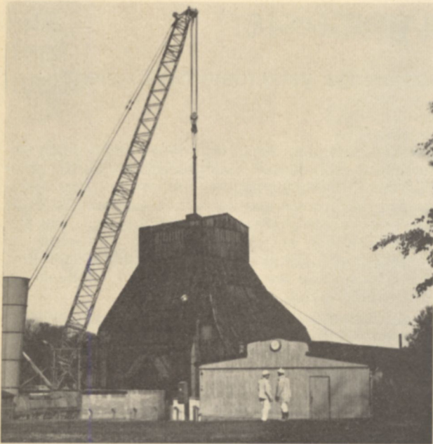
Einhängen der Pumpen in den Schacht 5
