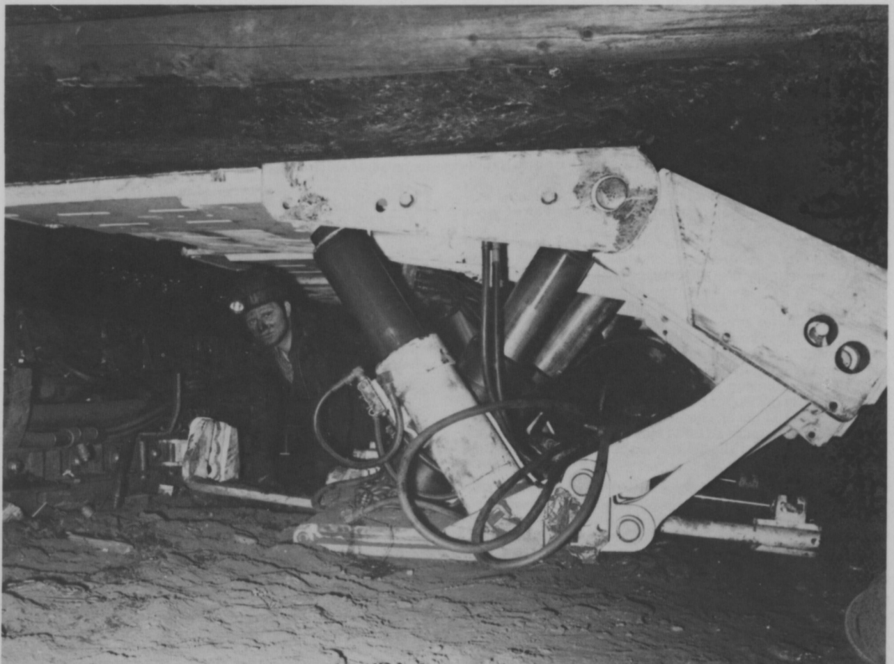
Gespannschild nach dem Setzen; gut erkennbar die Bruchabschirmung und die vorzügliche Gestaltung des Fahrweges.
