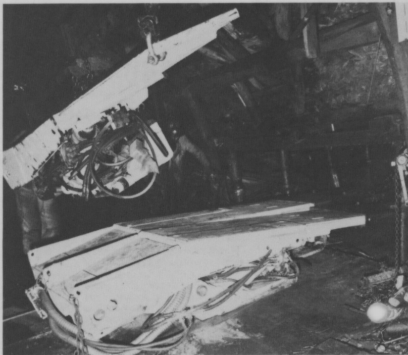
Transport einer Gespannschildhälfte mittels Einschienenhängebahn zur Montagebühne am Aufhauen sowie ein komplett montiertes Gespannschild vor dem Einbringen ins Aufhauen.
