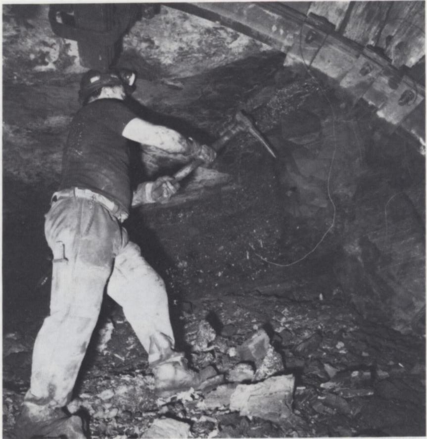
Bereifen eines Streckenortes nach dem Schießen
