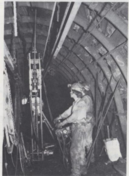
Herstellen der Bohrlöcher für die Ankerstangen. Alimak-Bohrwagen mit Montabert Bohrerhammer T 25
