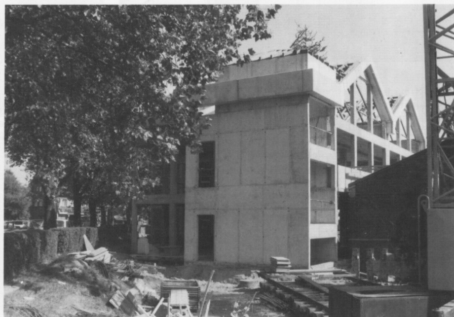
Der 2. Bauabschnitt der Bergberufsschule
