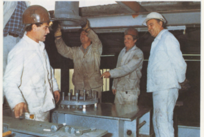
Einlassen der Leitungsrohre Schacht 2
