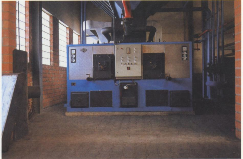
kung berechnet, obwohl dieser Mehraufwand aus vielerlei Gründen mitunter gar nicht erwünscht ist; dementsprechend wirtschaftlicher wird die Investition. Lediglich der Großkessel mit 580 kW Leistung wurde mit zusätzlicher automatischer Entaschung versehen; diese ist bei kleineren Anlagen infolge des geringen Ascheanfalls des Anthrazits nicht erforderlich.
