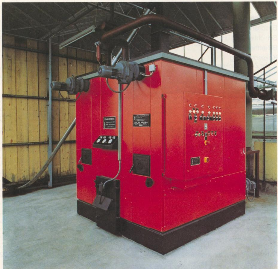
nung selbst automatisch erfolgen. Die Entschlackung der Kessel sollte möglichst automatisch sein und die Entfernung der Schlacke und der Asche sollte von Hand erfolgen. Die Entfernung der Schlacke und Asche kann natürlich auch automatisiert werden, jedoch stehen hier die Kosten in keinem Verhältnis zu dem Ergebnis.
