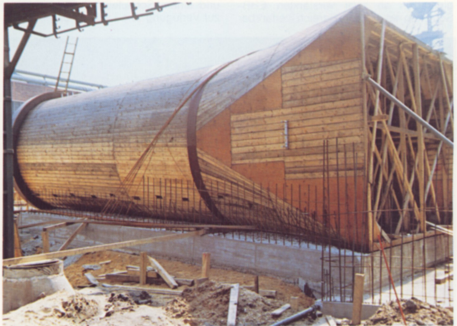
Schalung der Ansaugkanäle
