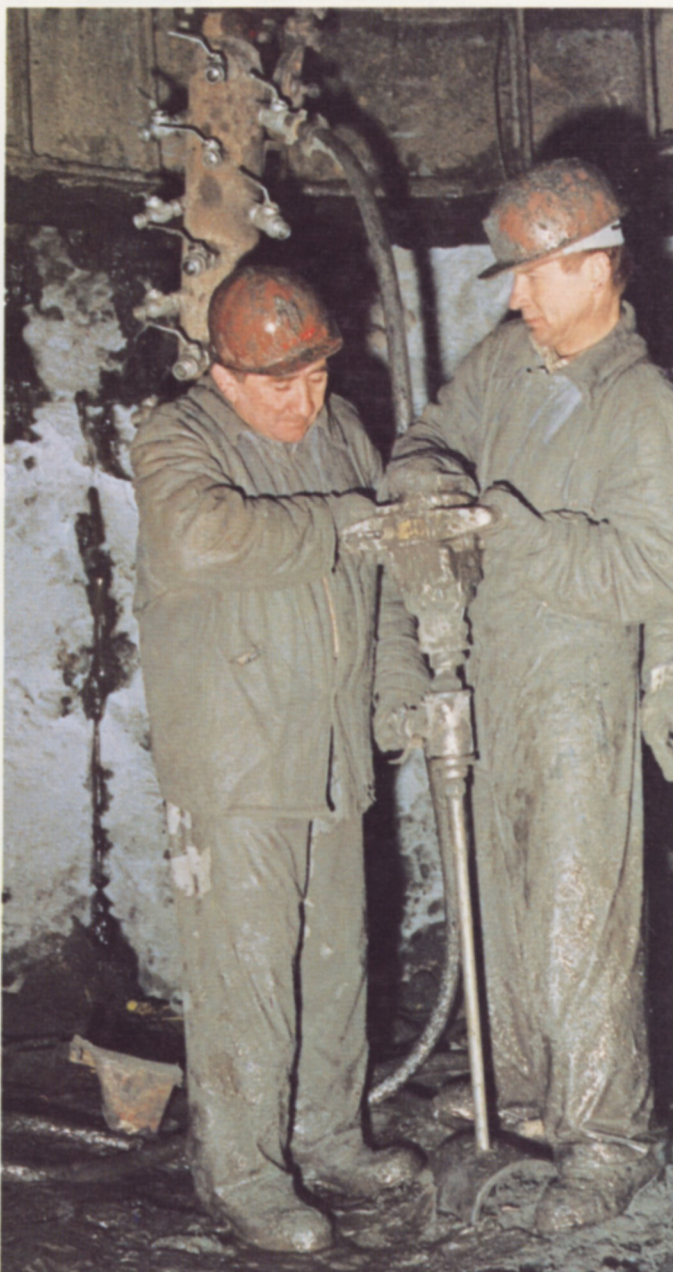
Bohrmannschaft auf der Sohle Schacht 8
