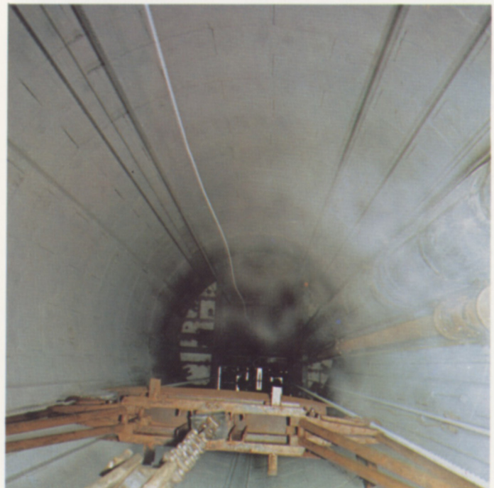
Blick in den Frischwelterschacht 8
