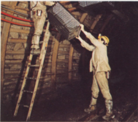
Montage der Wassertrogsperrren
