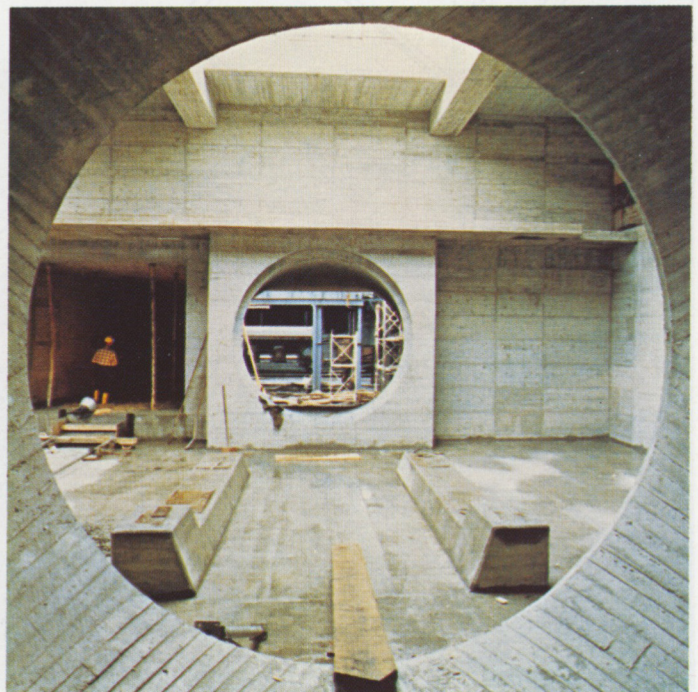
Grubenlüfter Schacht 2: Die Rohbauarbeiten sind abgeschlossen
