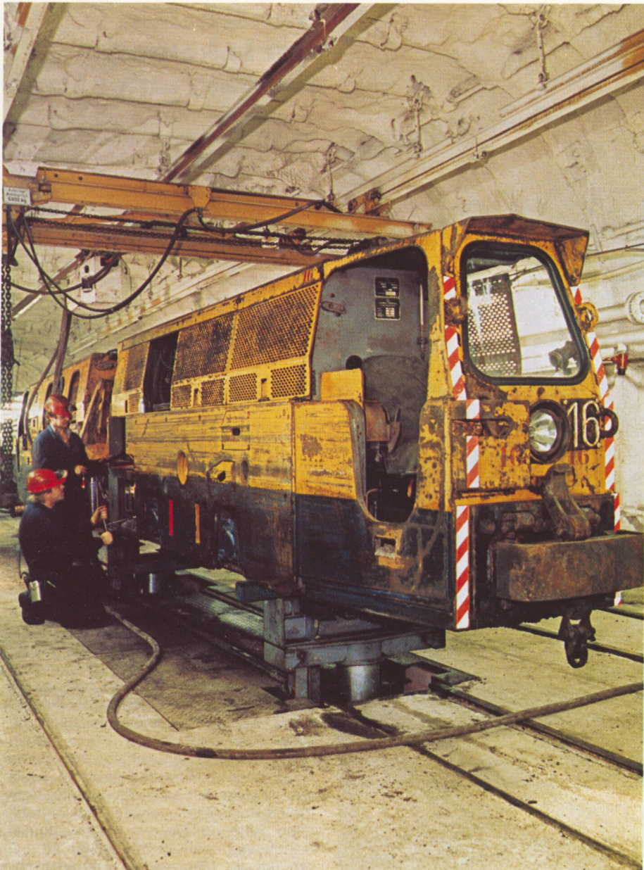
Reparaturarbeiten: 34-t-Doppellokomotive auf der Hebebühne ...
