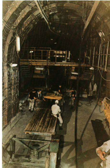
Blick in die Maschinenkammer am Kopfpunkt des Diagonals 4603 (Abb. 5)
