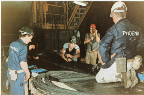
Ausrichten der Seile vor der Gurtvulkanisation (Abb. 9)
