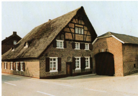
Riedgedeckte Häuser in Schwaam
