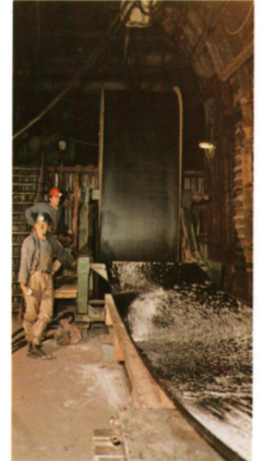
Aufhängung des Wickelkerns auf dem Wickelbock beim Abspulvorgang (Abb. 6)
