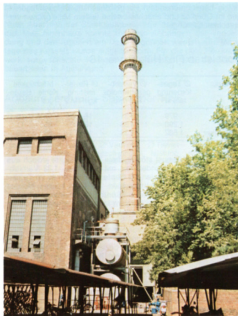
Heizkraftwerk: Kamin während der Bauarbeiten
