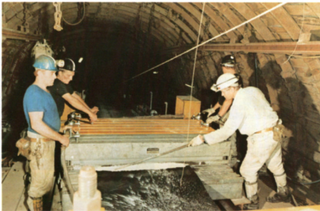
Einbringen des Gurtes unter 19° Neigung; Abfangen der Hangabtriebskraft mit Wagener-Klemmen (Abb. 7)
