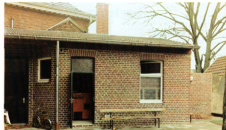
Pfarrhaus-Anbau als Heizzentrale; die Kohlelieferung erfolgt per Schlauch durch das Oberlichtfenster
