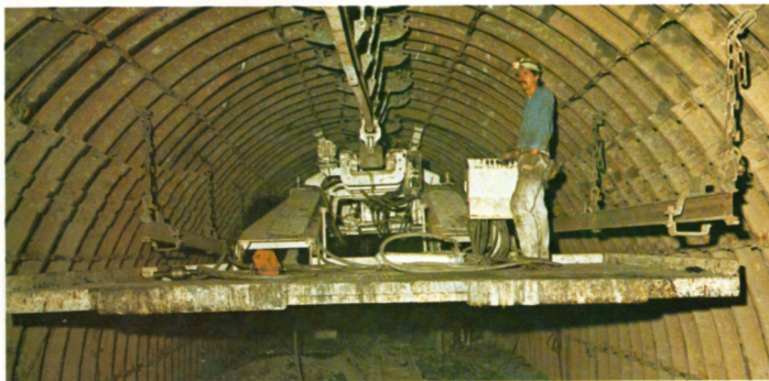
Deilmann Streckenarbeitsbühne 5011/ASV/AB in der 2. Richtstrecke/Osten, 4. Sohle
