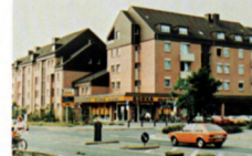
Vom Heizwerk „Kaarster Straße“ beheizte Wohnobjekte
