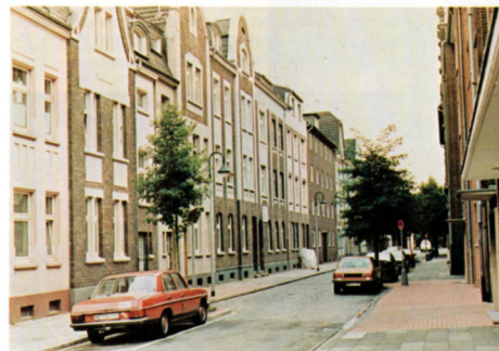
Vom neuen Heizwerk „Heerdter Straße“ beheizter Strabenzug
