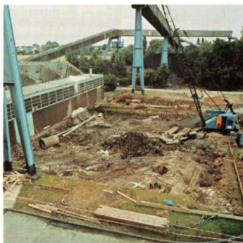
Baustelle Heizkraftwerk Dortmund-Derne
