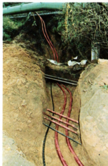
20 kV-Kabelverlegung einschließlich Steuerkabel an der Ferndamplleitung
