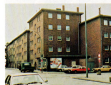
Beheiztes Wohnobjekt des Heizwerkes „Blücher-Dyckhoffstraße“
