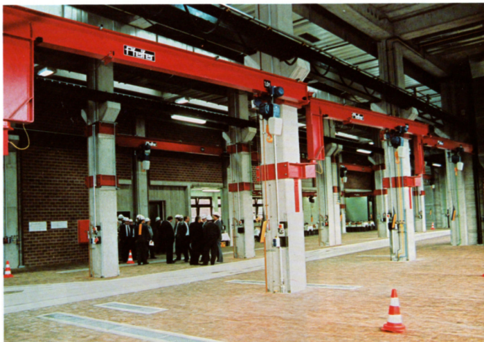
Die Hydraulikwerkstatt im Erdgeschoß für die Instandsetzung leichterer Maschinenelle.
