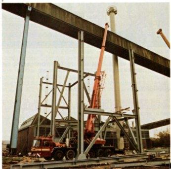
Baufortschritt Heizkraftwerk Dortmund-Derne
