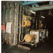
Lecklaufwanne unter einem Beacomat-aggregat
