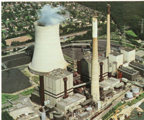
Gemeinschaftskraftwerk West: Leistungsanteil für Sophia-Jacoba 225 MW (Blöcke I+II rechts). Links: Kraftwerk Voerde, Blöcke A+B. Freigabe-Nr. 11.953/87, Reg.-Präsident Münster
