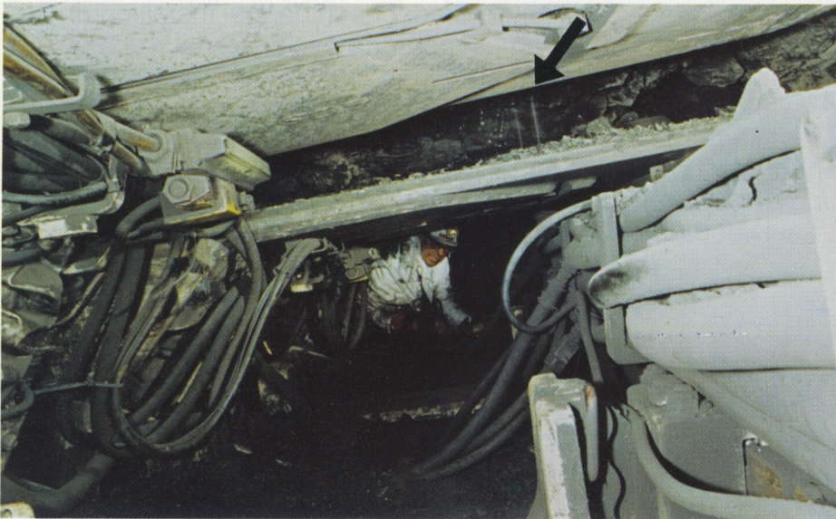
Schildausbau mit Bedüsungseinrichtung
