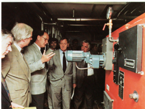
SJH-Mitarbeiter Fiedler erklärt dem NRW-Innenminister Dr. Schnoor die Funktion des Heizkessels
