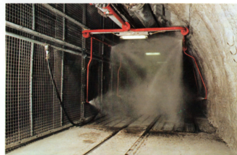
Funktion der Anlage im Brandfall
