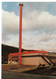
Vollautomatisches Kohleheizwerk der Bundesbahnbetriebswerke Hagen
