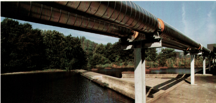
Fernwärmemasse zum Gewerbegebiet Rheinstraße
