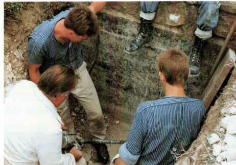
Auch die Betonfundamente der Friedhofseinfriedung werden „bewältigt“
