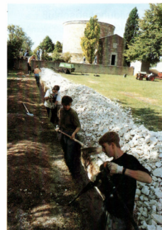
Mit großem Eifer bei der Sache: Ein 80 cm tiefer Graben wird aus dem Kreideboden herausgeschlagen
