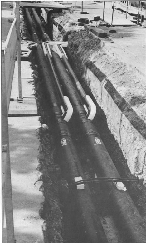
Ein kurzer Abschnitt der über 14 Kilometer langen neuen Fernwärmetrasse mit „Abzweigung“ zu einem privaten Endverbraucher
