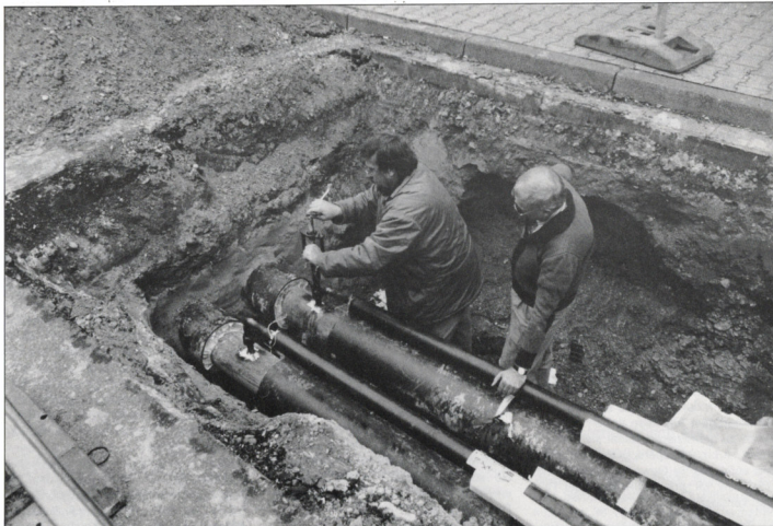
Herstellung eines Hausanschlusses DN 25 an Hauptrohr DN 200
