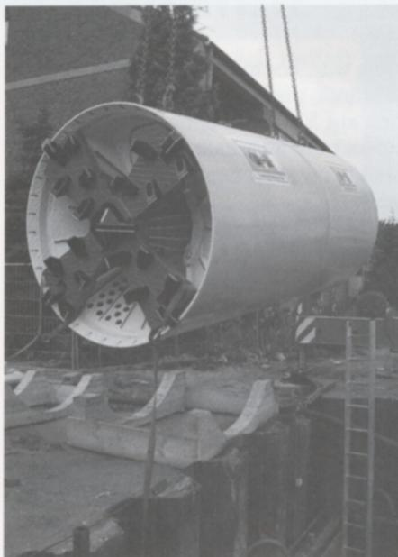
Luftnummer: Ein Kran hievt den Bohrkopf in die Startgrube.
